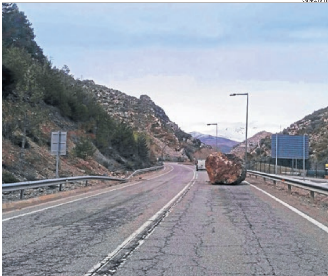
Imagen de la roca que cortó el viernes un carril de la N-260 en la entrada del túnel de Erinyà.
